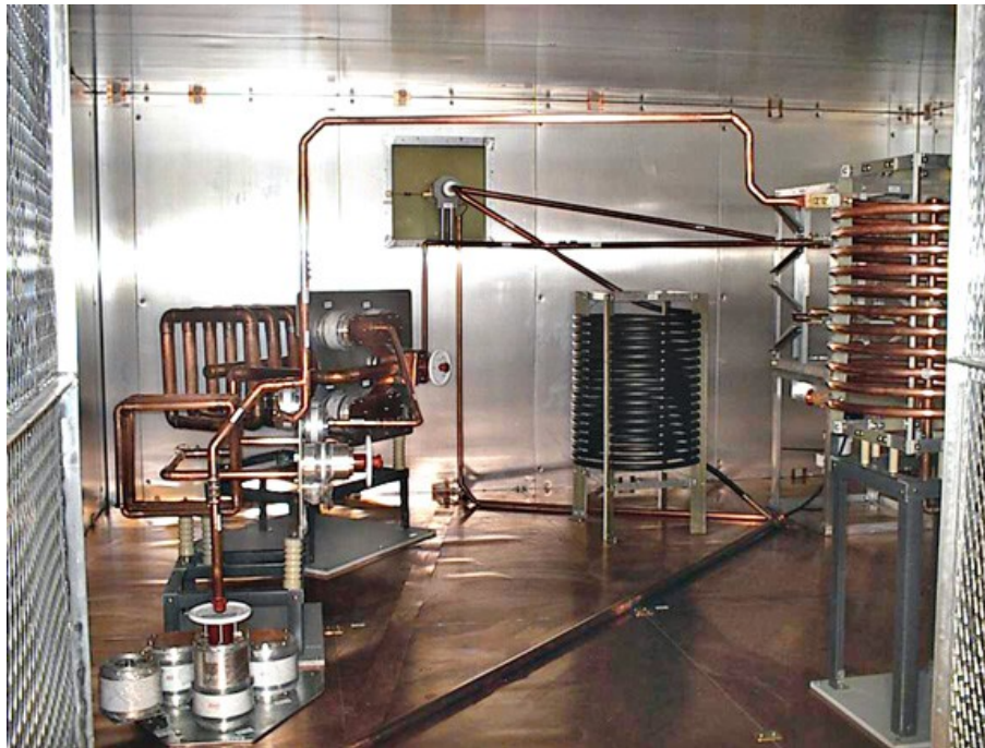
Fig.19 – Immagine dell'interno di una moderna cabina di sintonia per frequenze OM
