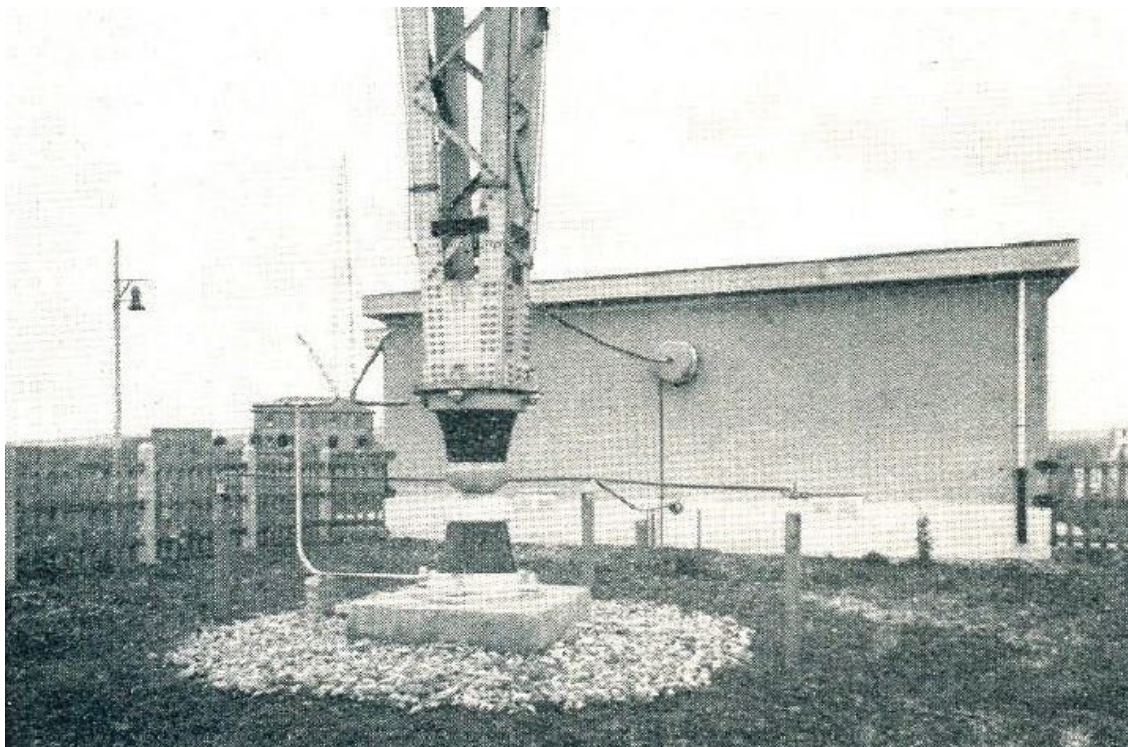
Fig. 3 – Particolare della base della torre di trasmissione principale
