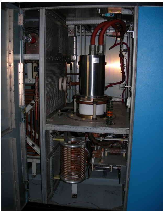
Fig. 8 – Thomcast TMW2600 - Vano tubo RF e vano circuito di accordo anodico
