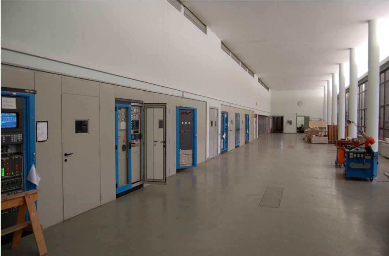
Fig. 7 – In primo piano i due Thomcast TMW2600 da 600KW; in fondo il 300KW Marconi
