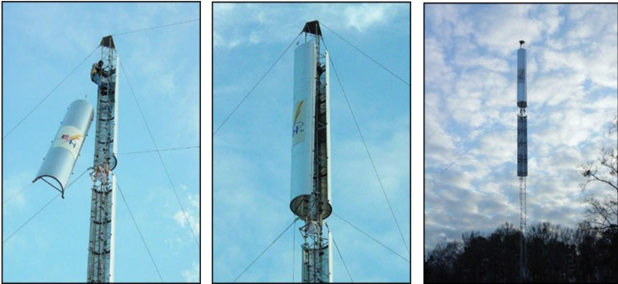
Fig.23 – Fasi di montaggio di un'antenna EH per uso broadcast
