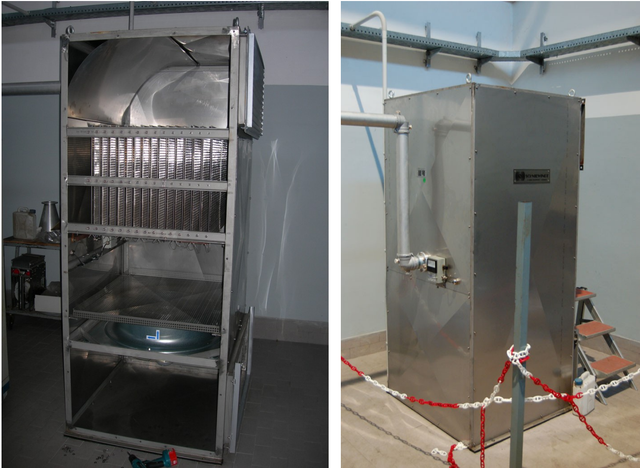
Fig.21 – Carico fittizio OM raffreddato ad aria previsto per l'impianto e di Roma e di Squinzano
